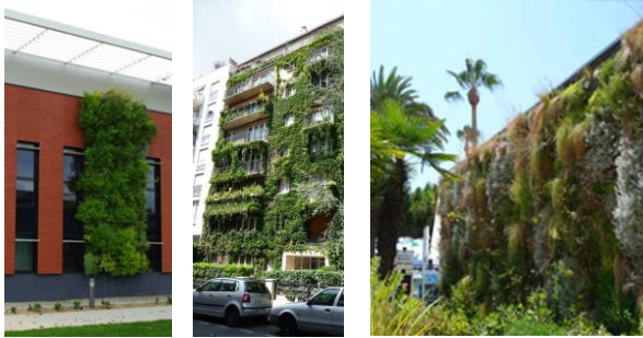
Façades végétalisées non admises
