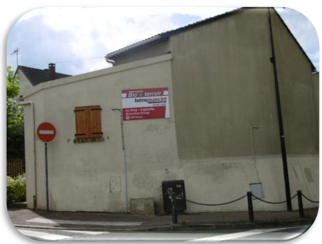
Préenseigne murale en infraction au regard de la réglementation nationale : aposée sur un mur de bâtiment non aveugle
