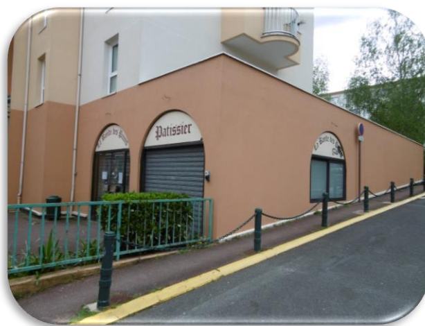
Enseignes bien intégrées avec les ouvertures sur façade.
