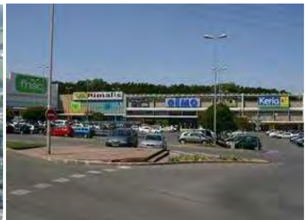
Centre commercial Villebon 2 Source : SIAM 2012
