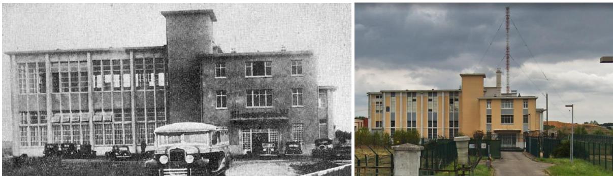
Centre émetteur de Villebon-sur-Yvette : 1935 - 2019
