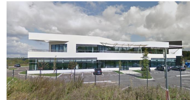
Construction en cours et achevées de bâtiments d'activités tertiaires : illustration du siège social du groupe de distribution pharmaceutique TEDIS
