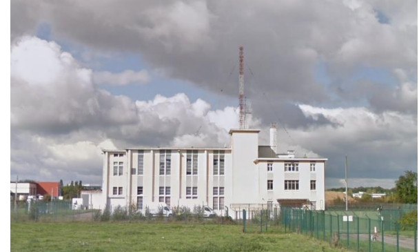
Centre émetteur TDF de Villebon-sur-Yvette construit en 1934
