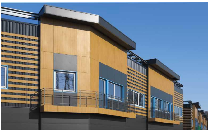
Bâtiments neufs à usage mixte bureaux-activités le long de la RD 59
