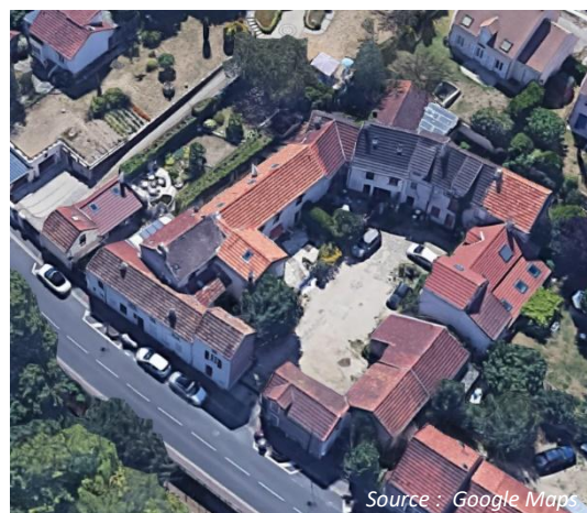
Cour commune: 42 rue des Casseaux
