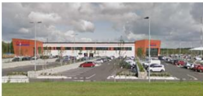
Siège social et magasin-entrepôt COSTCO France
