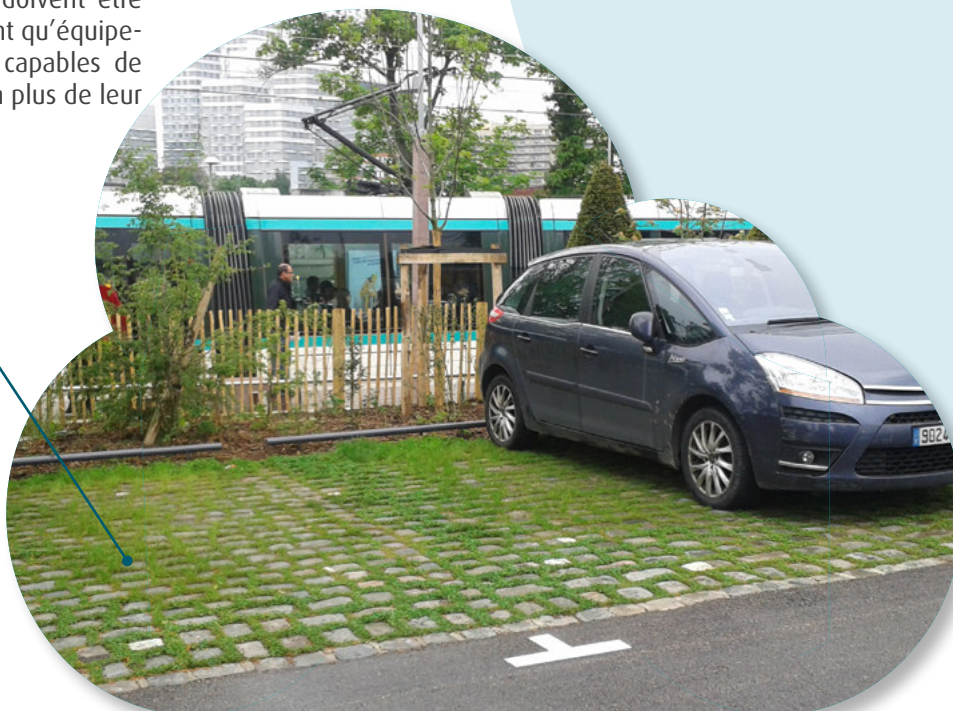
Parking infiltrant évitant l'imperméabilisation, Fresnes (DRIEE)
