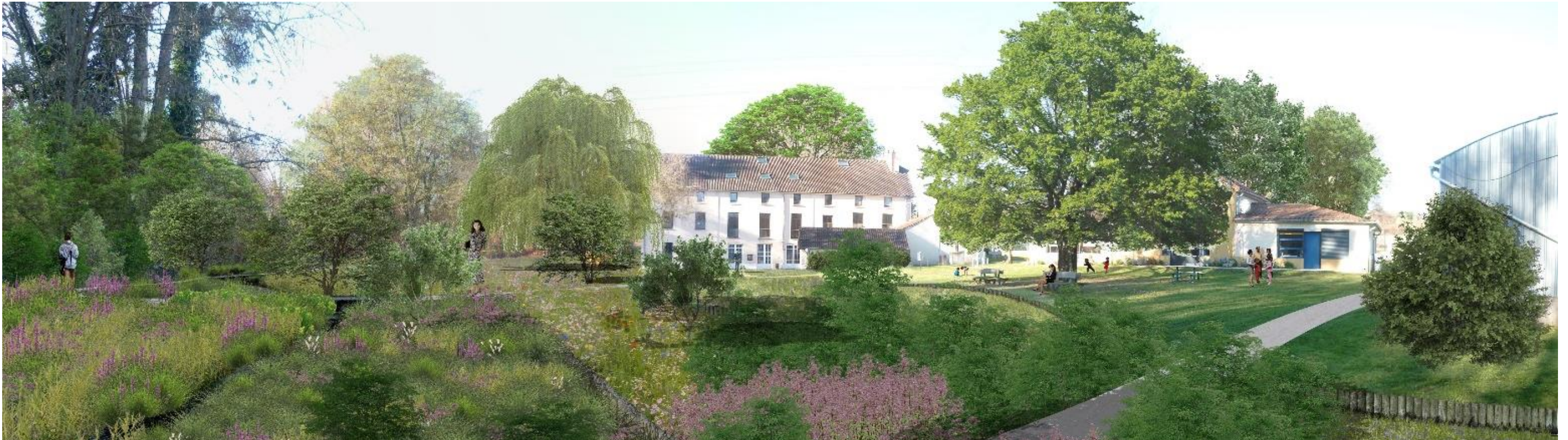
Figure 26 - Point de vue n°1 du moulin de Bretèche depuis le préfabriqué - après travaux (variante optimale)
