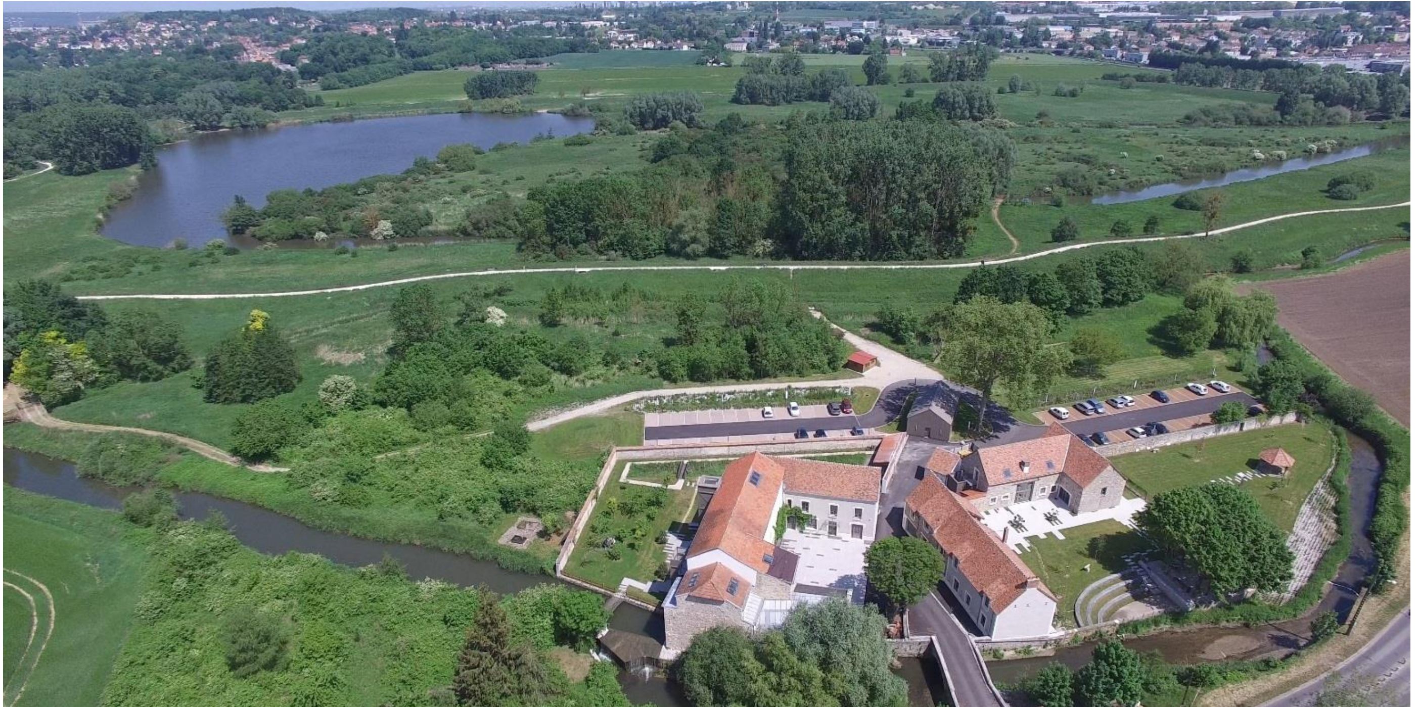
Figure 35 - Point de vue n°2 - Moulin de Saulx avant travaux
