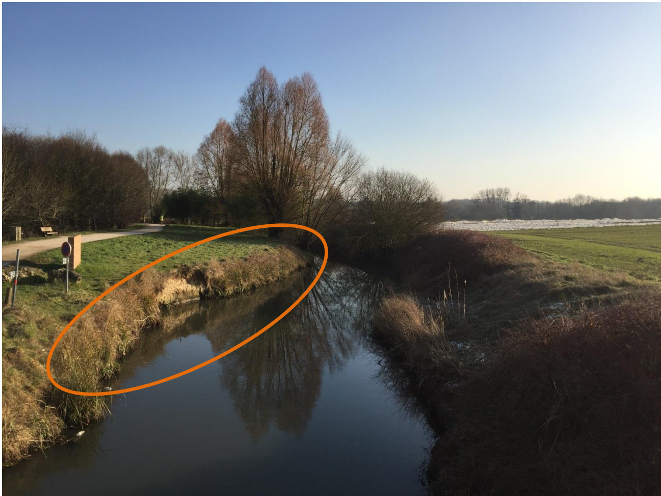
Figure 10 - Déstabilisation de la berge gauche de l'Yvette en aval du pont de la route de Champlan
