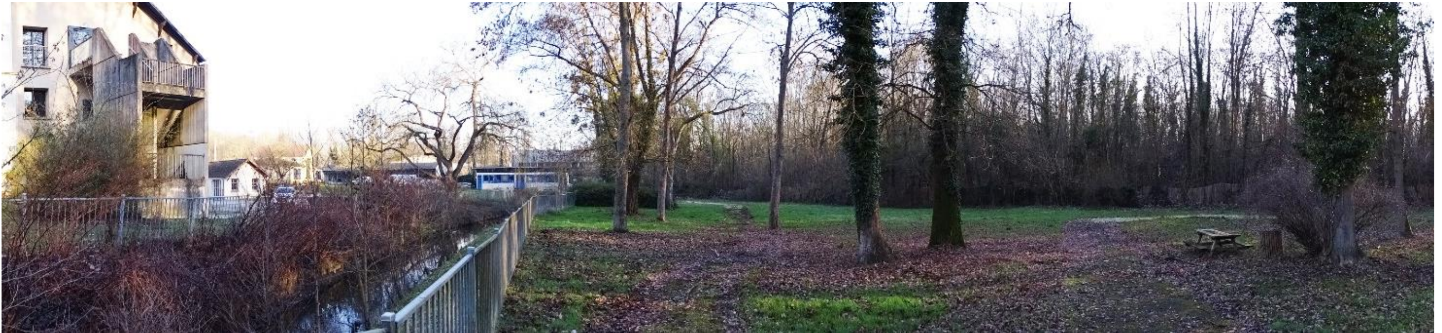
Figure 27 - Point de vue n°2 du moulin de Bretèche depuis la rive Sud de l'Yvette - avant travaux
