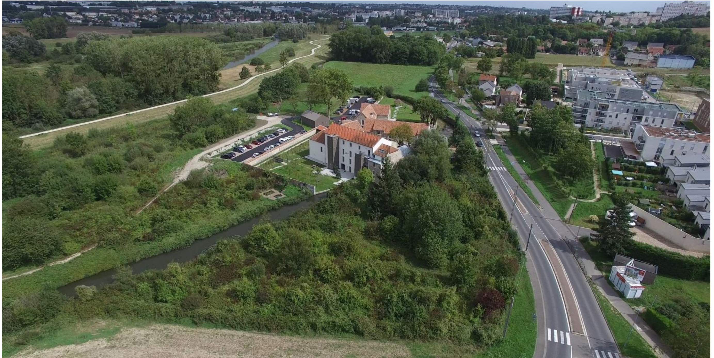
Figure 33 - Point de vue n°1 - de Moulin de Saulx avant travaux
