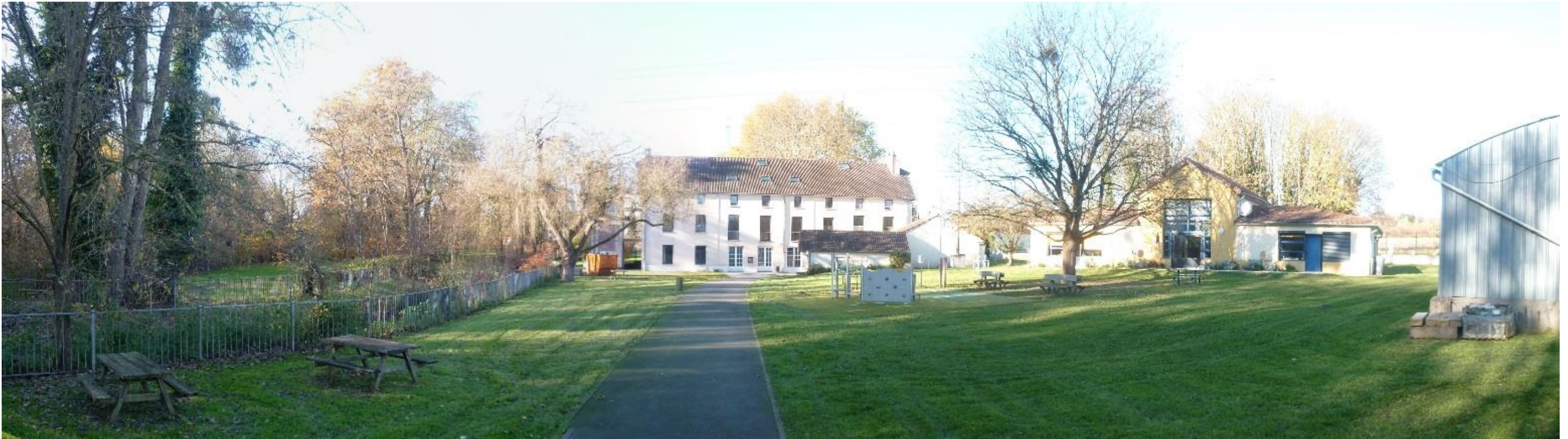
Figure 25 - Point de vue n°1 du moulin de Bretèche depuis le préfabriqué - avant travaux
