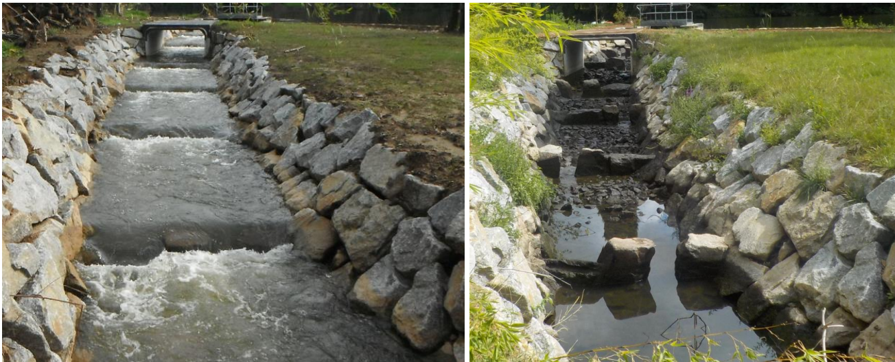
Figure 19 - Exemple de bras de contournement en rangées périodiques réalisé sous MOE SCE (Mareuil sur Lay, 85)
