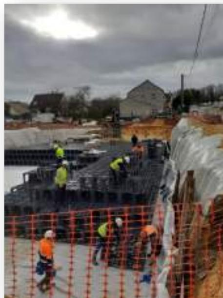
Figure 1 : Chantier de création d'un bassin eaux pluviales avenue Georges Boillot à Linas
