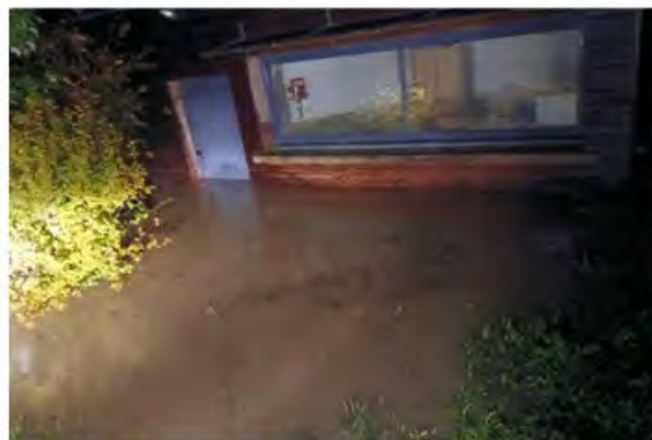
Inondation de la STEU de Dampierre en Yvelines
